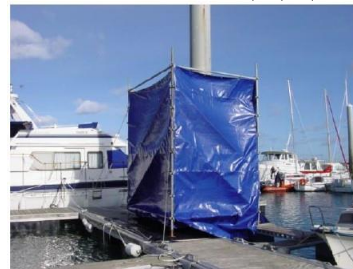
Figure 52 : Exemple de dispositif de confinement mis en place pour le sablage et la peinture des pieux
