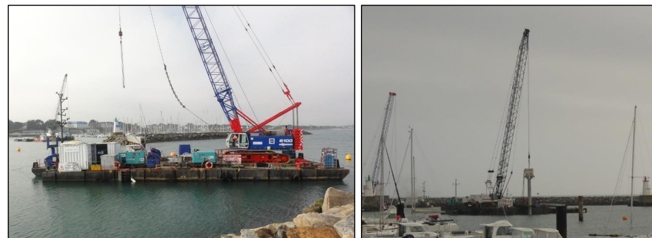
Figure 51 : Exemple de barges pour travaux maritimes – Port Haliguen à Quiberon (source : INGEROP)
