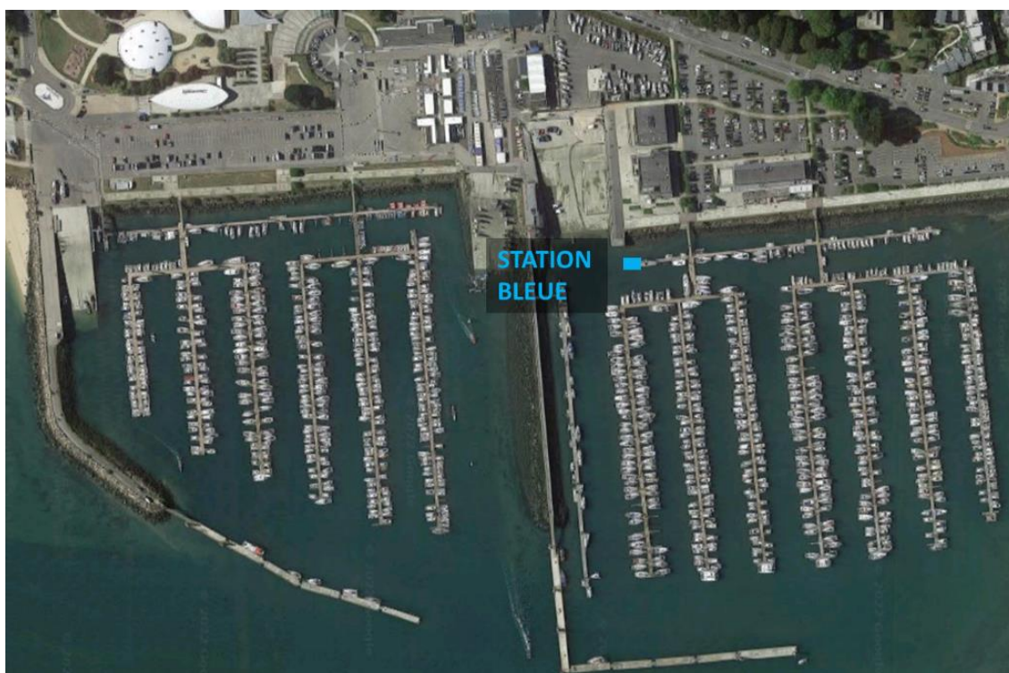
Figure 55 Localisation de la station bleue (station permettant l'évacuation des eaux noires et grises)
