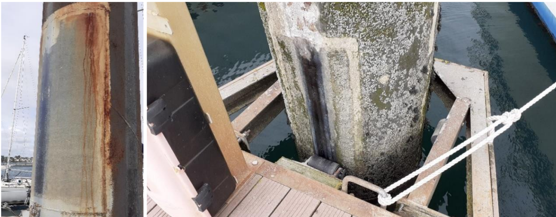
Figure 34 : Photos des pieux des bassin SUD prises les 29 et 30/09/2021 par Artelia
