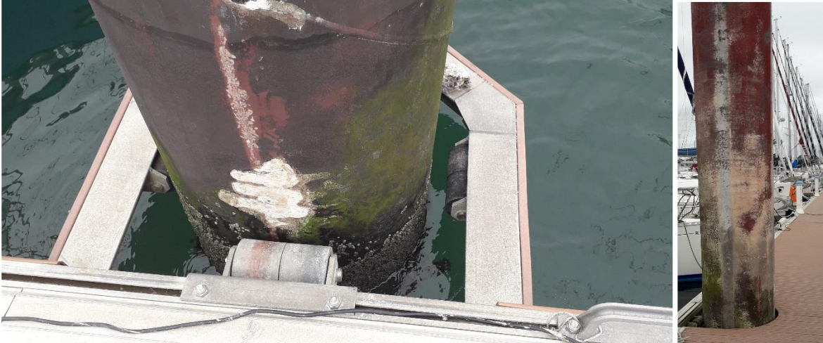
Figure 36 : Photos des pieux des bassin NORD prises les 29 et 30/09/2021 par Artelia
