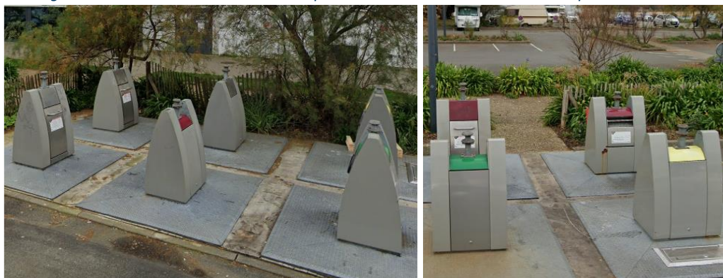
Figure 54 : Conteneurs enterrés situés à proximité du bassin nord au niveau des restaurants du Tour du monde et de l'Admirals
