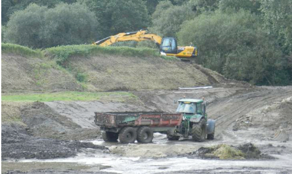
Figure 40 : Convoi empruntant le plan incliné vers la lagune de ressuyage durant les travaux de 2012 (source Syndicat)
