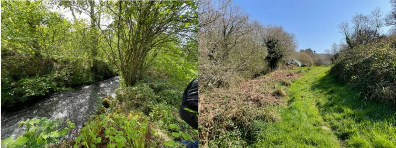
Figure 85 : À gauche, zone du franchissement à créer, à droite piste à renforcer
