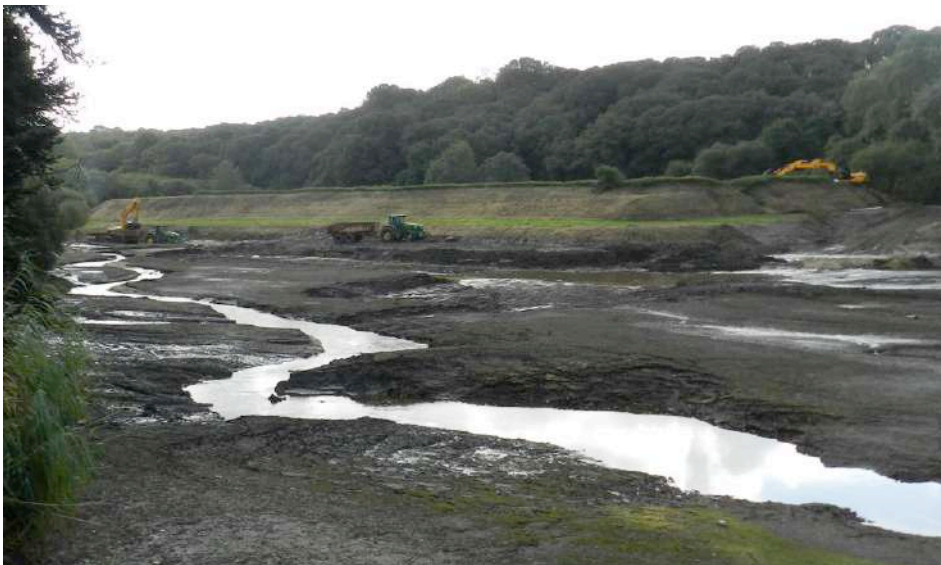
Figure 42 : Vue des travaux de curage de 2012. On aperçoit le lit original de la rivière au premier plan (source syndicat)
