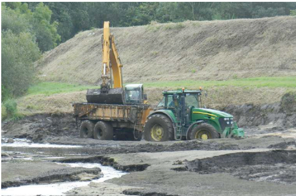
Figure 39 : Pelle avec tracteur agricole avec benne lors du curage de 2012 (source Syndicat)
