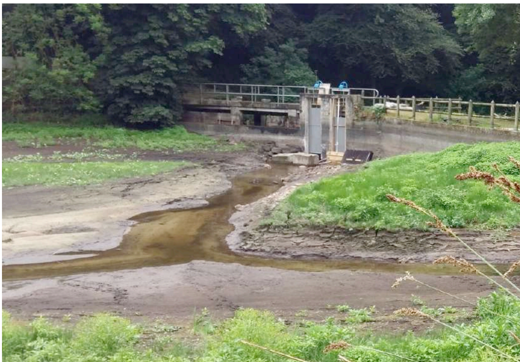
Figure 38 : Au centre sont visibles les vannes E1 et E2 sur la retenue de Baniguel en 2012 (source Syndicat)
