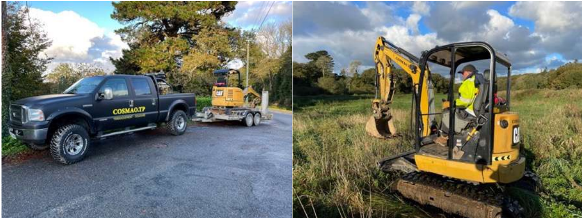
Figure 59 : Acheminement de la mini-pelle et sondage dans la lagune (source Gaïa)
