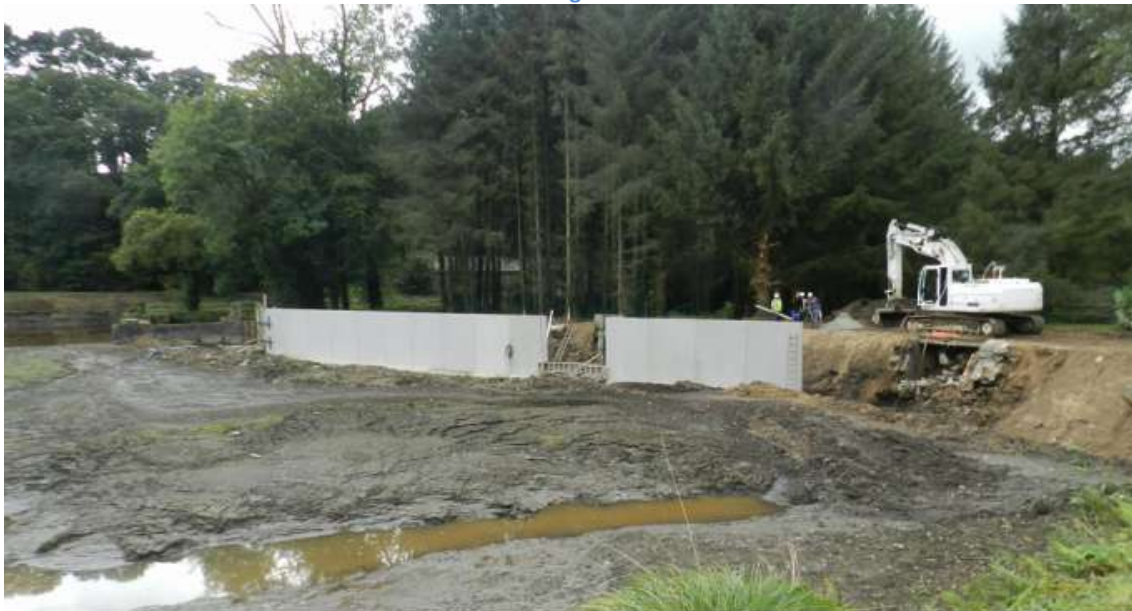
Figure 36 : Travaux de confortement de la digue de Moulin Neuf en 2010 (source Syndicat)
