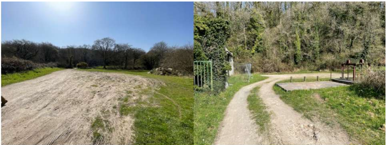
Figure 24 : Terre-plein du Moulin de Carman à renforcer et franchissement de la vanne du Moulin
