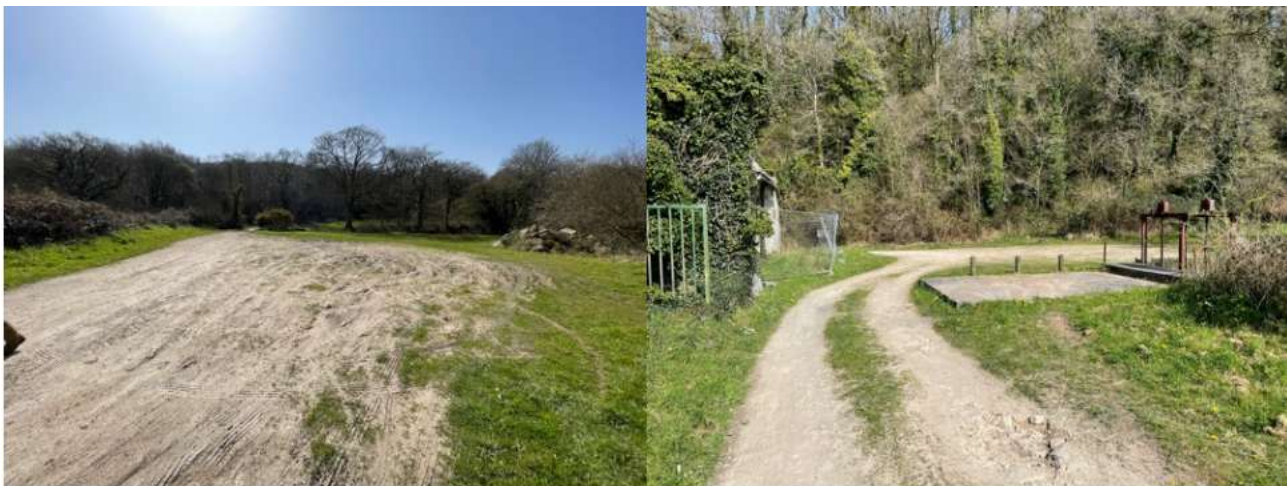
Figure 86 : Terre-plein du Moulin de Carman à renforcer et franchissement de la vanne du Moulin
