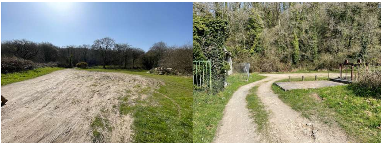
Figure 114 : Terre-plein du Moulin de Carman à renforcer et franchissement de la vanne du Moulin
