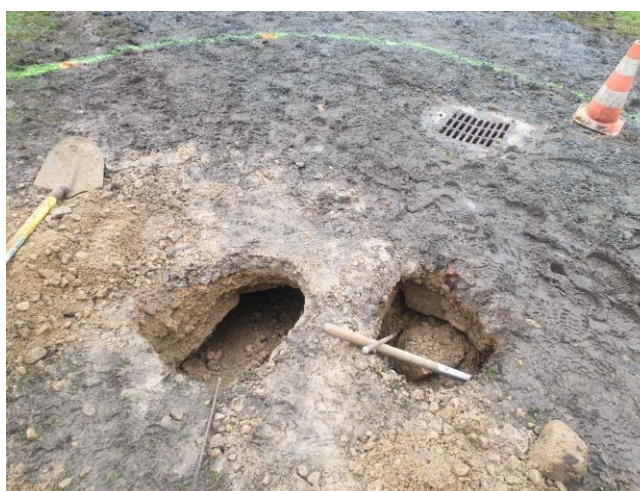
Désordres et cavités identifiées dans la digue de Baniguel, nécessitant des travaux de confortement et de génie civil.
