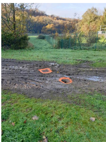
Désordres et cavités identifiées dans la digue de Baniguel, nécessitant des travaux de confortement et de génie civil.
