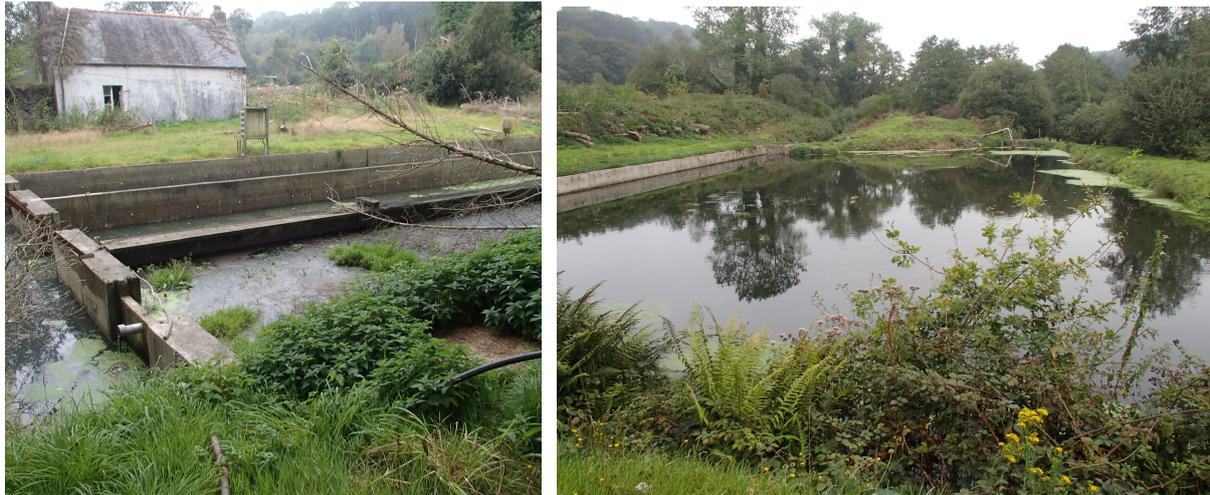
**Illustration 8** Vue du bassin de collecte recevant les boues extraites du filtre rotatif (à gauche) et l'eau restante en sortie d'élevage (à droite). On notera la lame fixe du déversoir côté gauche du grand bassin
